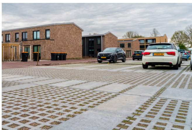
Parkeren op waterdoorlatende parkeerterreinen (Beeld: Haarsma Infra)
